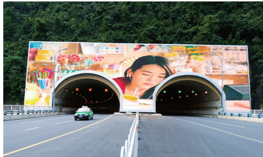
贵阳最美隧道
